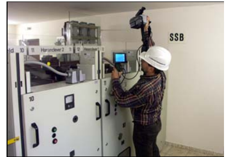
Bild 2 getrennter Aufbau von Monitor und IR-Kamera
