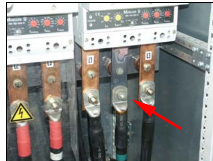
Bild 9 Leistungsschalteranschluss
