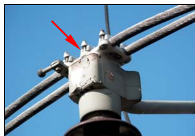
19 und 20 IR- Bild und Foto eines 110kV Pantographentrenners, aufgenommen mit einem 24° Normalobjektiv
