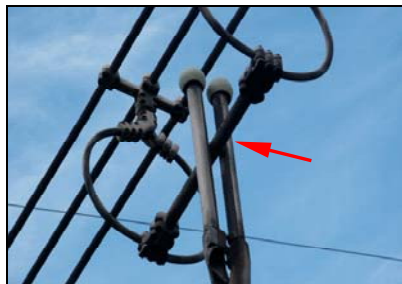
2 und 3 Heißstelle am Hauptkontakt eines 380 kV Scherentrenners
