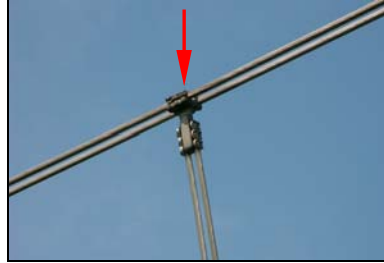
11 und 12 IR-Bild und Foto einer 110kV T-Klemme identisch der Klemme im Bild 10 und 11 jedoch aufgenommen mit einem 7° Teleobjektiv
