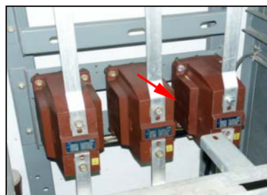
21 und 22 IR- Bild und Foto eines 20kV Stromwandlers, aufgenommen mit einem 45° Weitwinkelobjektiv
