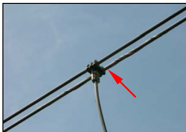
13 und 14 IR-Bild und Foto eines Aderbruchs an einem 110kV Überspannungsseil aufgenommen mit einem 7° Teleobjektiv
