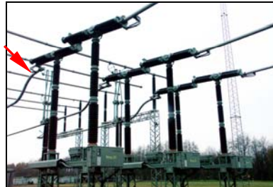
17 und 18 IR- Bild und Foto eines 380kV Flachanschlusses an einer Leistungsschalterverbindung, aufgenommen mit einem 7° Teleobjektiv
